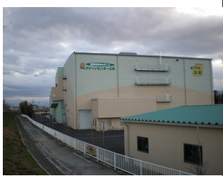
広陵クリーンセンターは建設費が48億円でした
