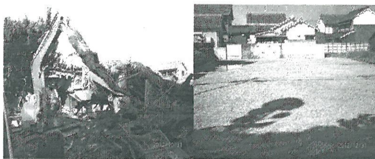
(解体工事開始！)
