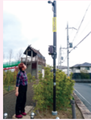
要望の高かった竹取公園に防犯カメラが設置されました
